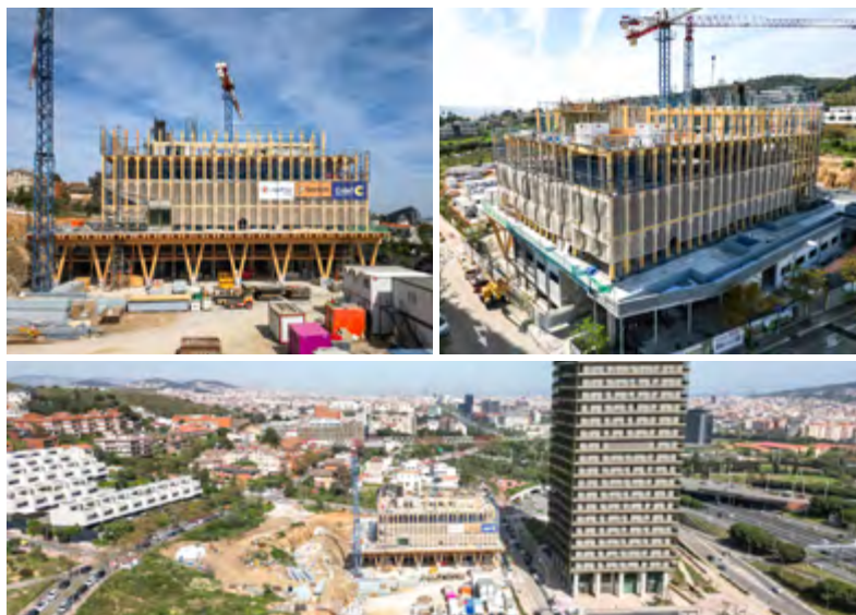
Imatges de l'avanç de la construcció del centre (abril de 2025)
